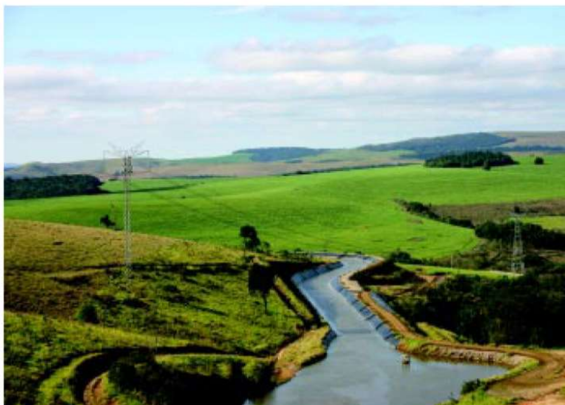
Obra construída pela Pesqueiro para canalizar água às turbinas
